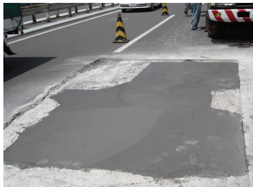
E T Cレーン段差解消補修
