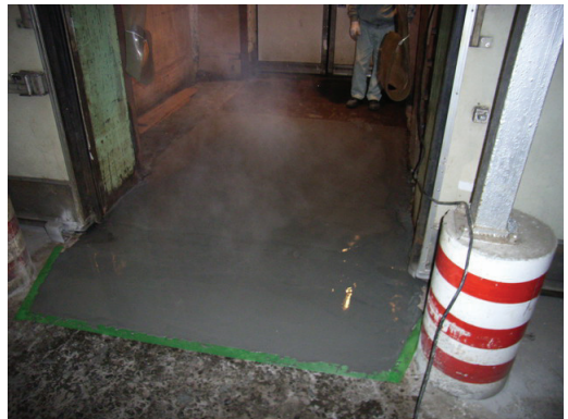
冷凍倉庫出入口の床面補修
