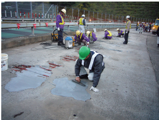
ジョイント後打ち部の緊急補修
