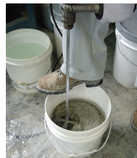
電動ドリルでの練混ぜ
