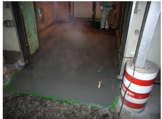
冷凍倉庫出入口の床面補修
