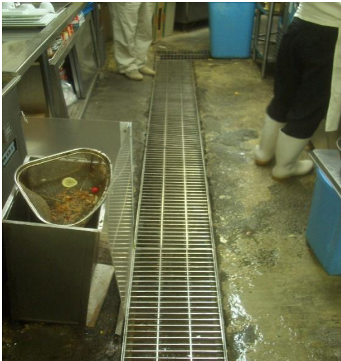
施工前状況写真
