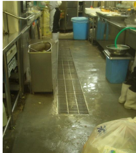
施工後約一ヶ月経過、良好
