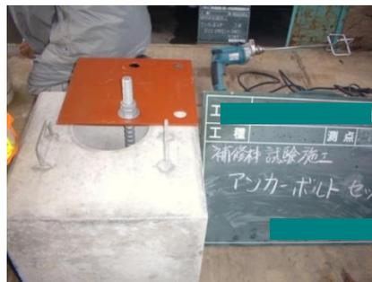
コンクリートブロック孔内ケレン状況      アンカーボルト セット      M22
