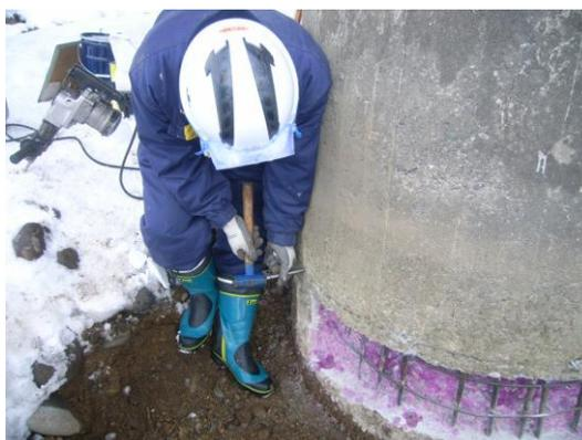
⑪既設鉄筋防錆材塗布状況
