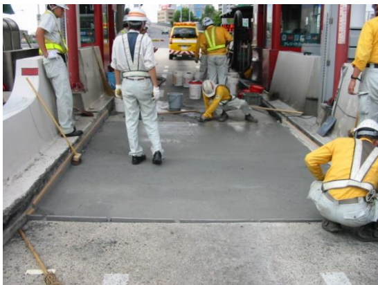
TR 17缶 打設完了
