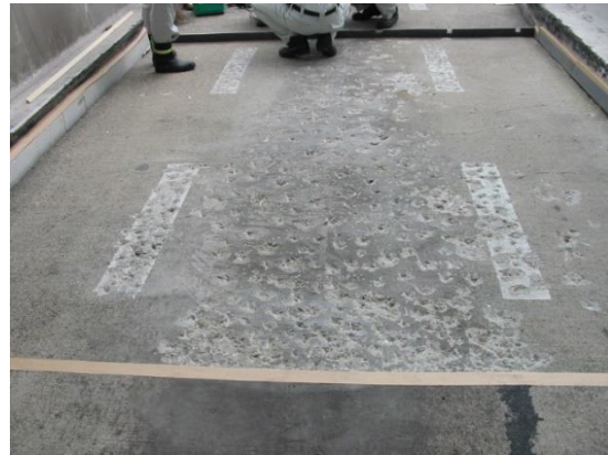
下地処理完了
