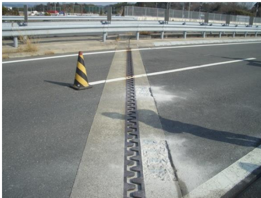
伸縮継手部全景
