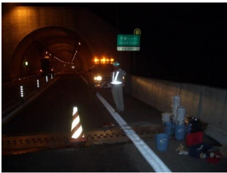
橋梁ジョイント全体風景
