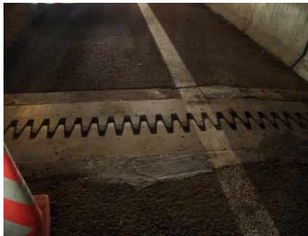
施工完了（打設時間約10分）
