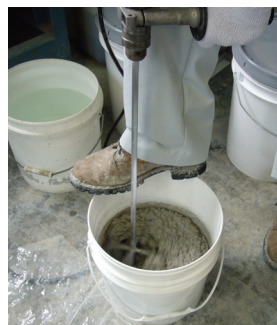
電動ドリルでの練混ぜ
