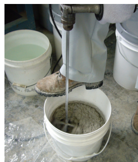
電動ドリルでの練混ぜ
