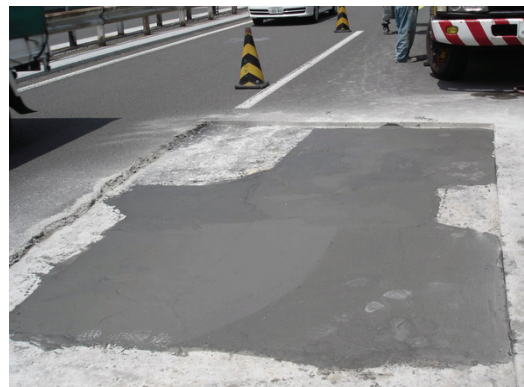
E T Cレーン段差解消補修
