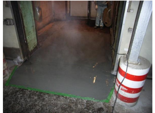
冷凍倉庫出入口の床面補修
