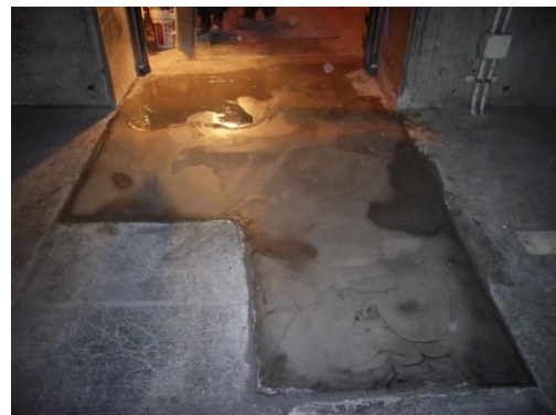
施工完了（補修箇所③）
