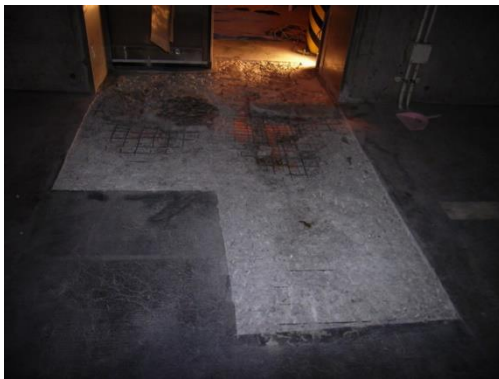
はつり完了（補修箇所③）
