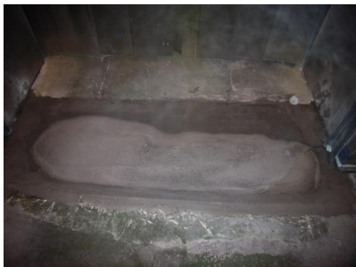
施工完了（補修箇所②）
