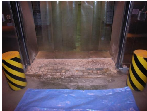
はつり完了（補修箇所②）
