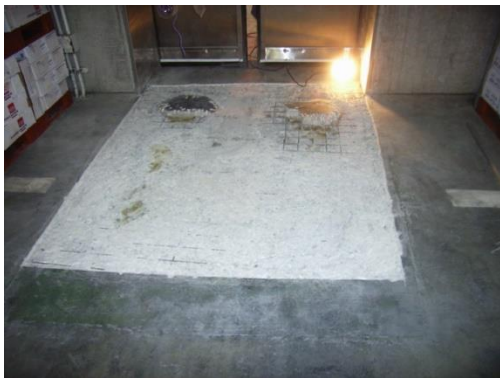
はつり完了（補修箇所①）
