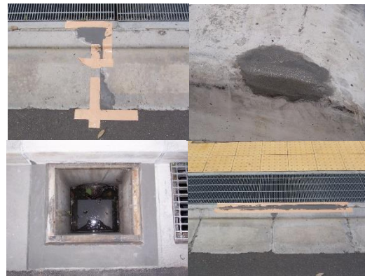
プレキャスト部の欠損箇所も補修
