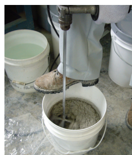
電動ドリルでの練混ぜ
