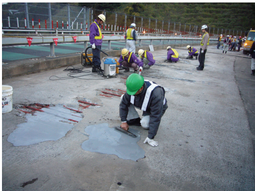
ジョイント後打ち部の緊急補修
